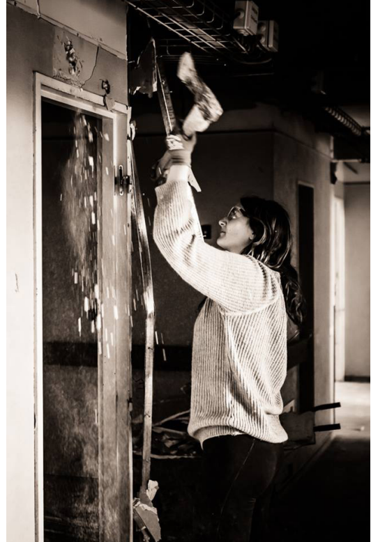
Travaux à la Clinique de la Transition
