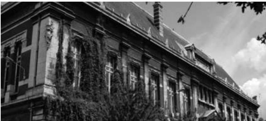
Maison de l'environnement à Lille
